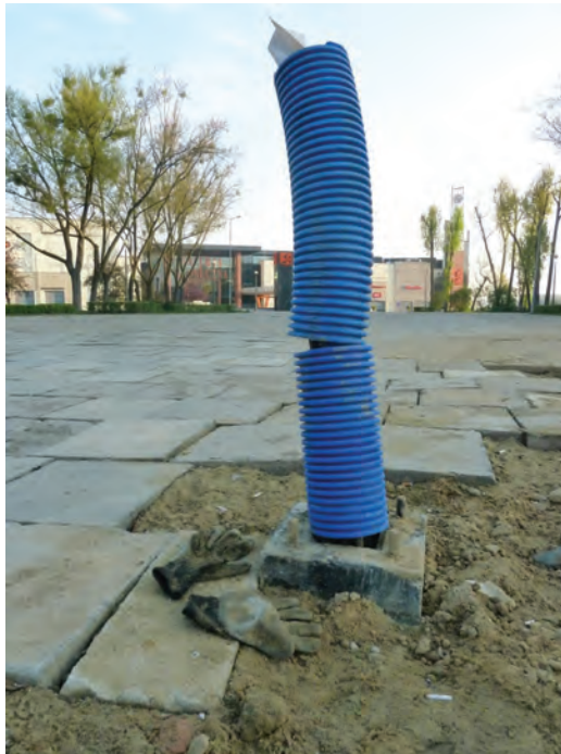
Ryc. 73. Prace remontowe na placu Jagiellońskim, w tle nowo otwarte centrum handlowe Galeria Słoneczna, kwiecień 2011, fot. Stanisław Zbigniew Kamieński
