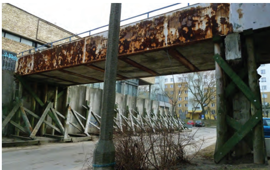
Ryc. 8. Osiedle „Ustronie” w Radomiu, fragmenty zabudowy wymagające gruntowego remontu, luty 2014, fot. Stanisław Zbigniew Kamieński
